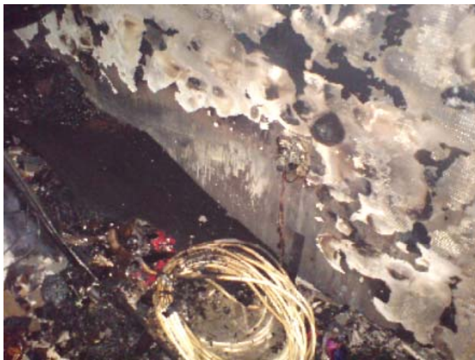
Рис. 1. Подовжувач, який був підключений до електромережі
