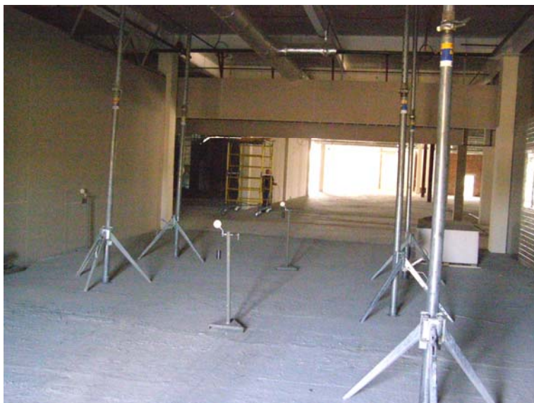
Рис. 3. Измерение прогибов железобетонной плиты прогибомерами БПАО
