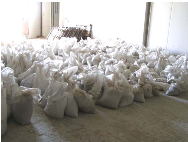
Рис. 2. Загружение ячейки перекрытия грузами (мешками с песком)
