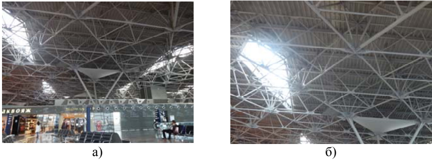
Рис. 2. Снимки аэровокзального комплекса «Внуково-1»: а – несущих конструкций в интерьере; б – опорных и соединительных узлов
