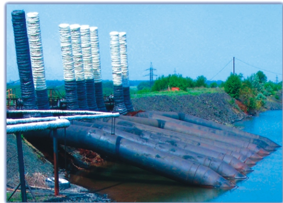
Водозабірна споруда сифонного типу (ПАТ «Північний ГЗК»)
