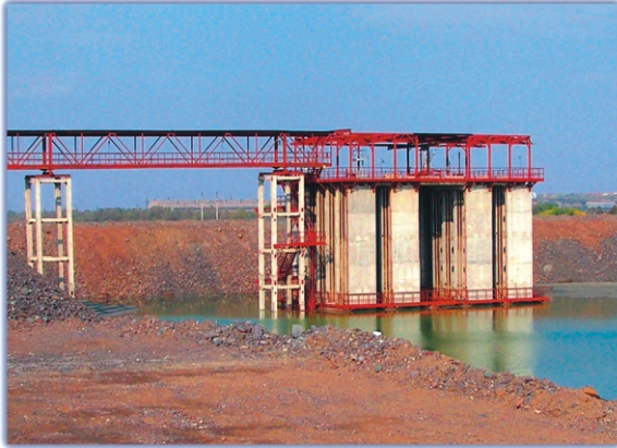
Водозабірна споруда шахтного типу (ПАТ «Інгулецький ГЗК»)
