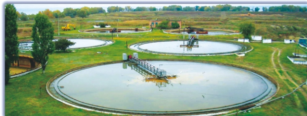
Каналізаційні очисні споруди. Радіальні відстійники (м. Черкаси)
