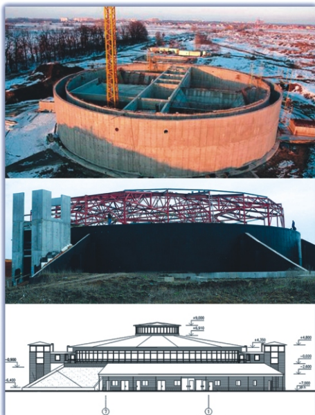
Реконструкція каналізаційних очисних споруд (м. Бориспіль)
