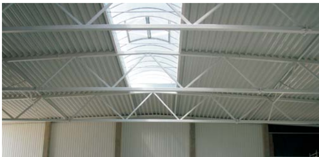
Профнастил Т135, смонтированный в беспрогонной схеме кровли при шаге ферм 6000 мм
