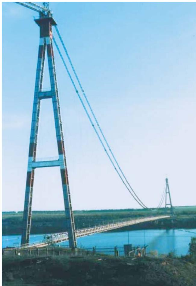
Рис. 1. Висячий мост через р. Днепр на трассе аммиакопровода Тольятти–Одесса
