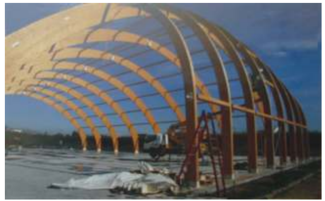
Рис. 4. Момент строительства здания
