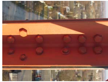
Рис. 9. Встановлення болтів меншого діаметра
