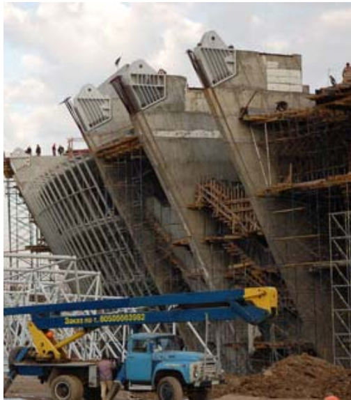
Рис. 4. Узлы опирания радиальных ферм
