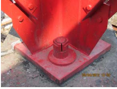
Рис. 5. Дефект гайки
