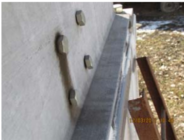
Рис. 10. Ослаблення болтового з'єднання
