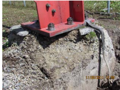
Рис. 2. Руйнування бетону фундаменту
