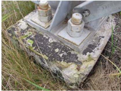
Рис. 1. Пошкодження гідроізоляції фундаменту
