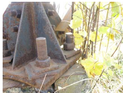
Рис. 4. Відсутність контргайок, гайки не затягнуті, корозія елементів
