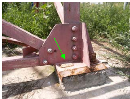
Рис. 3. Відсутність анкерного болта
