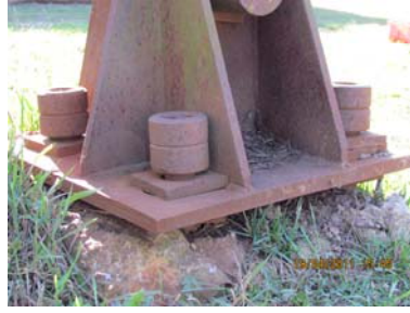
Рис. 6. Руйнування бетону фундаменту під дією динамічних навантажень
