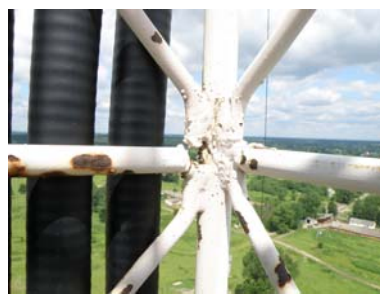
Рис. 13. Неналежна якість зварного з'єднання
