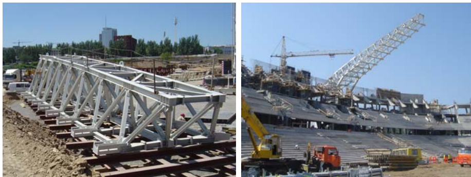
Рис. 2. Радиальная ферма покрытия
