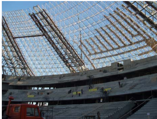
Рис. 6. Смонтированные фермы и структурные блоки покрытия
