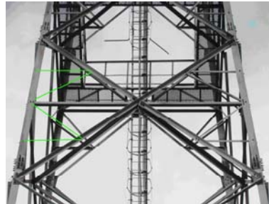
Рис. 8. Відсутність елементів решітки
