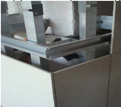
Рис.1. Конструктивні рішення несучої системи навісного вентиляваного фасаду з алюмінієвих сплавів
