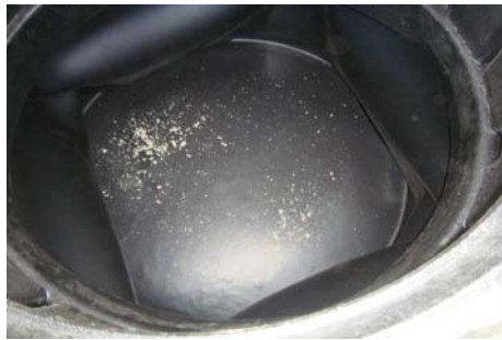
Рис. 3. Вмятины на стенках колодца КЛ-660 после испытаний
