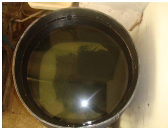
Рис. 7. Испытания на герметичность, вид сверху на колодец КЛ-660, заполненный водой
