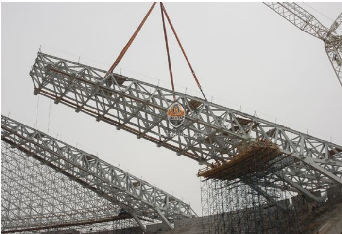
Рис. 3. Пространственная консольная ферма покрытия
