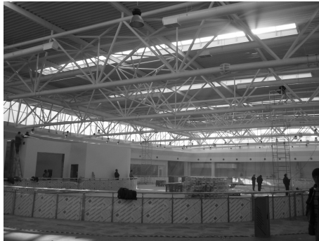
Рис. 9. Загальний вигляд конструкції покриття торговельно-розважального комплексу
