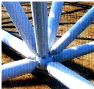
Рис. 5. Узел соединения системы «MERO»
