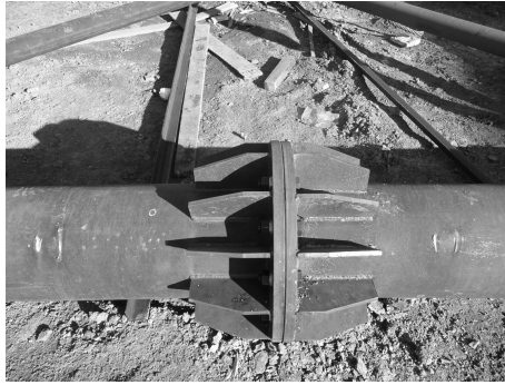
Рис. 8. Монтажне з'єднання нижнього пояса ферми конструкції на будівельному майданчику
