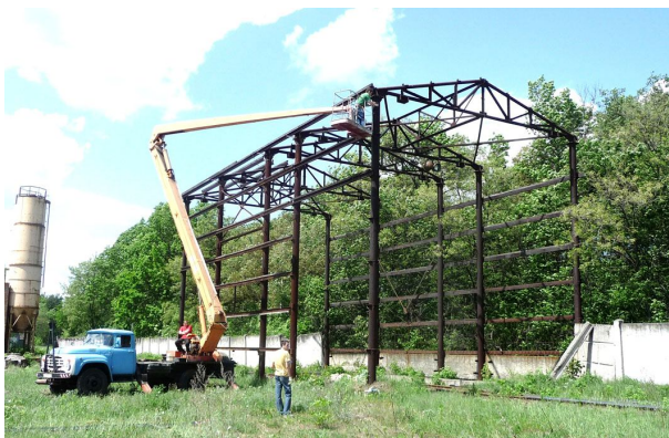
Рис. 2. Загальний вигляд випробуваного каркаса
