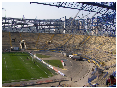
Рис. 7. Общий вид западной и северной трибун в процессе реконструкции
