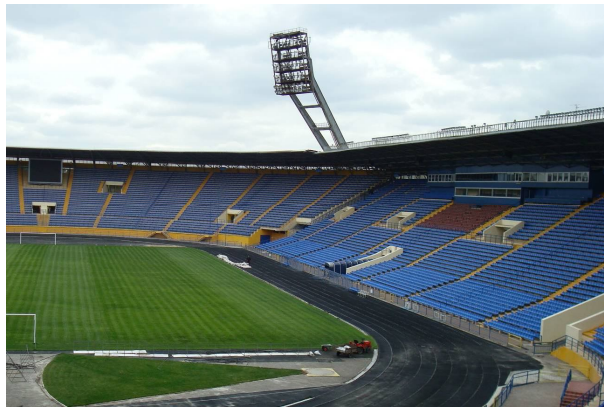
Рис. 1. Общий вид западной и южной трибун стадиона до реконструкции
