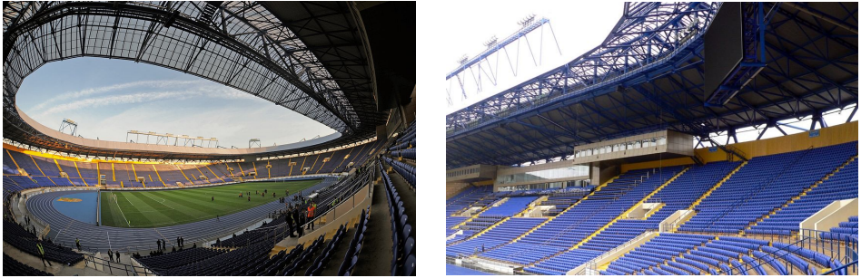
Рис. 3. Общий вид стадиона после реконструкции
