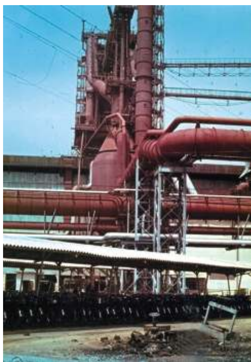
Загальний вигляд доменної печі
