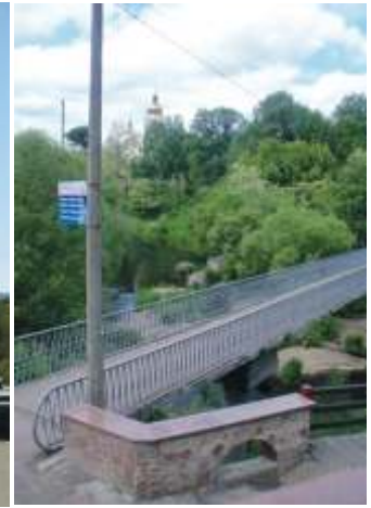
Пішохідний міст через р. Уж, м. Коростень
