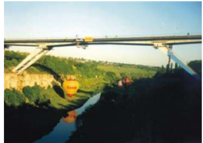
Суцільнозварний міст через р. Смотрич, м. Кам'янець-Подільський
