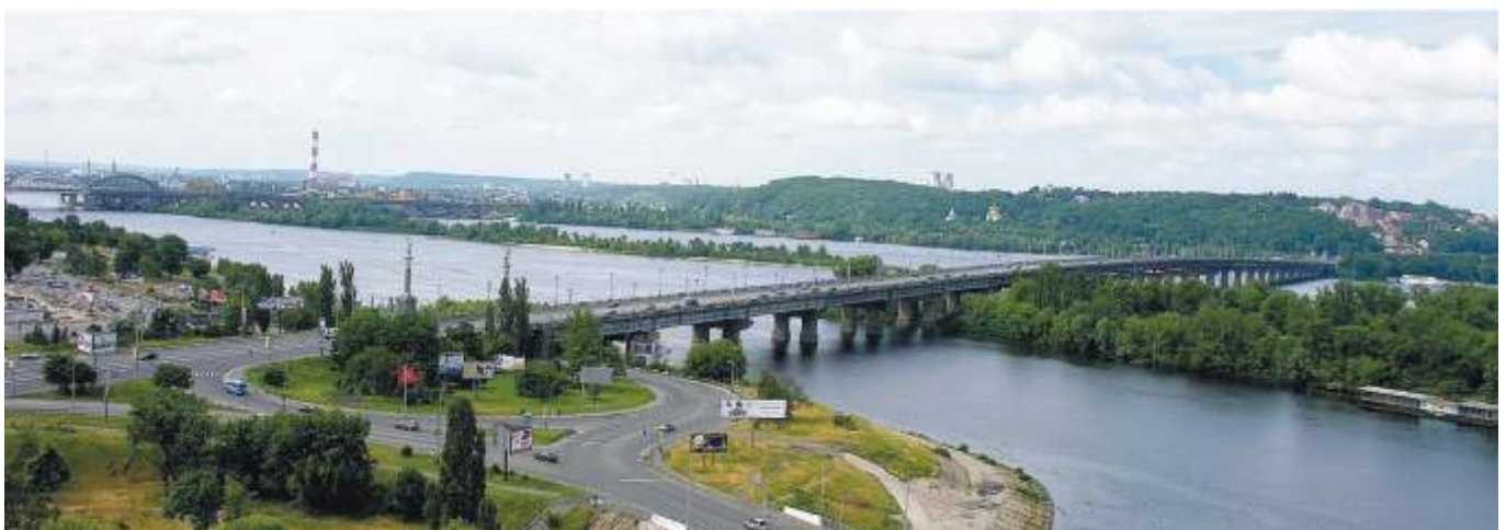
Суцільнозварний міст ім. Є.О. Патона через р. Дніпро, м. Київ
