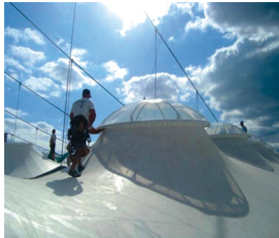
Вантові ферми та кільце. Вигляд покрівлі, ліхтарі
