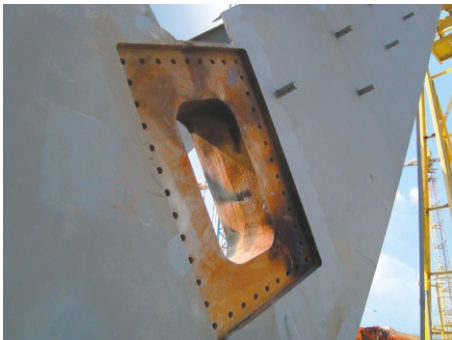
Стиковані колони (FC + RC). Вузол примикання ригеля LCR
