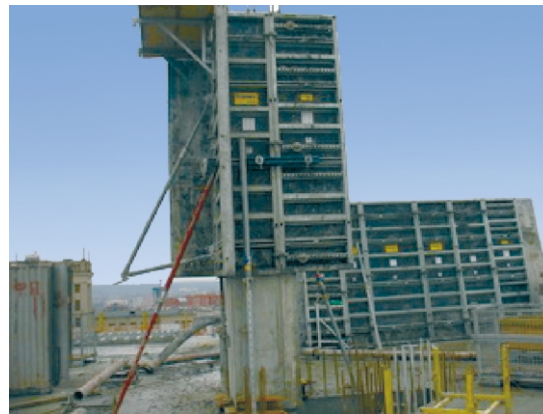
Рис. 2. Опалубка колонн
