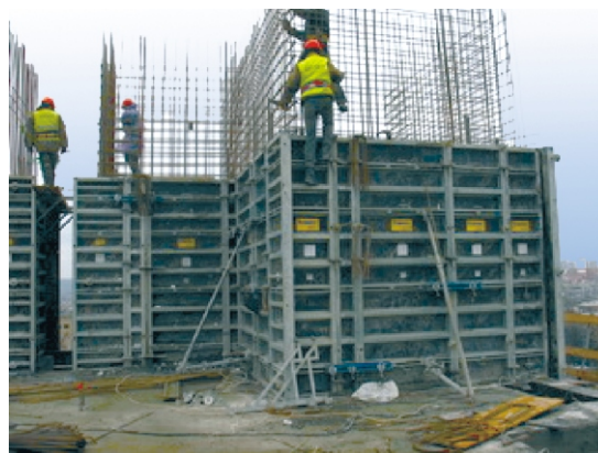
Рис. 3. Установка опалубки и армирование ядра жесткости
