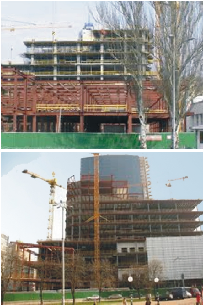
Рис. 2. Общий вид торгово-офисного комплекса со стороны Спортивной площади в процессе строительства
