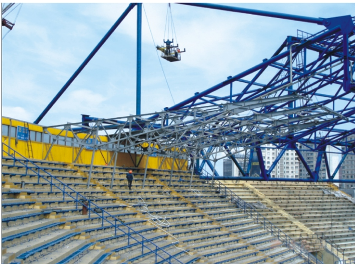
Рис. 5. Демонтаж существующих конструкций покрытия Южной трибуны
