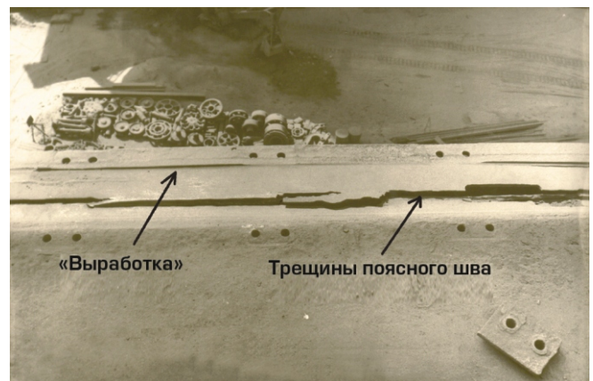
Рис. 4. Трещины в верхнем поясе балки
