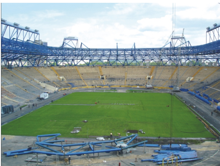
Рис. 6. Смонтированные конструкции покрытия трибун и укрупнительная сборка подстропильной фермы Южной трибуны
