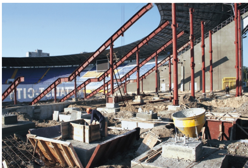
Рис. 2. Устрійство ростверка і монтаж несущих конструкцій Східної трибуни
