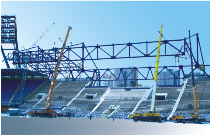
Рис. 4. Монтаж подстропильной фермы L = 64 м весом 46 т
