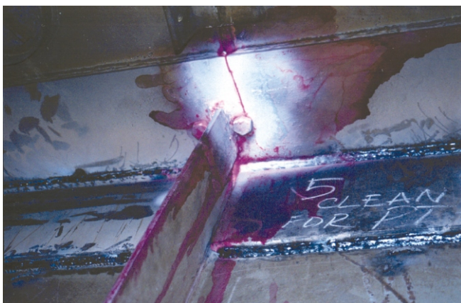
Рис. 3. Поперечная трещина в верхнем поясе балки
