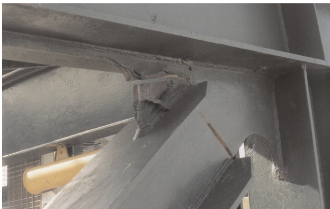
Рис. 4. Тріщина фасонки у верхньому вузлі передостанньої панелі бічної ферми стріли
