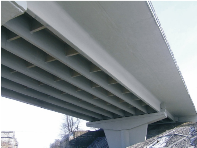
Рис. 5. Загальний вигляд шляхопроводу після реконструкції
