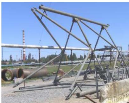
Рис. 3. Монтажный элемент башни после укрупнительной сборки
