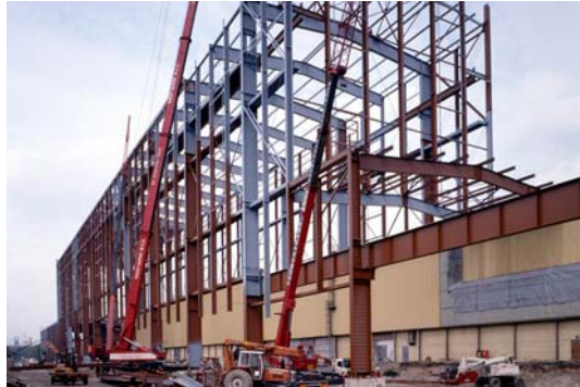
Рис. 6. Цех металлопрокатного завода в г. Линце (Австрия)
