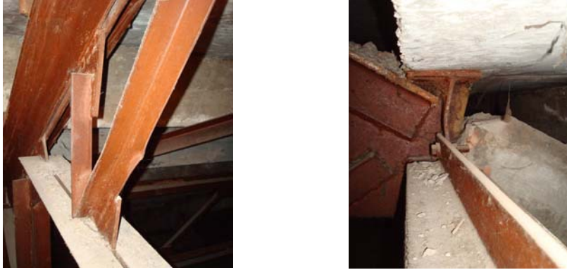
Рис. 6. Потеря устойчивости шпренгеля и упорного двутавра
