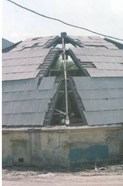
Рис. 2. Искривленне ребро купола
