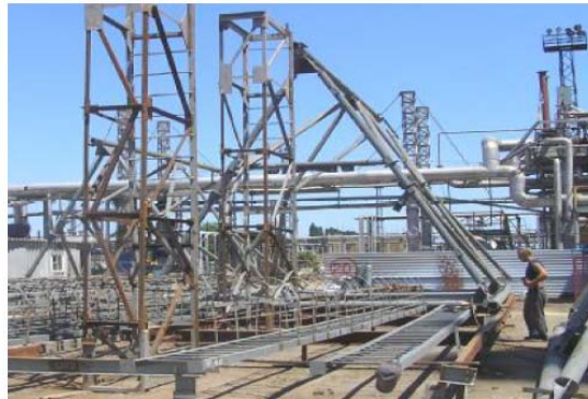
Рис. 7. Конструкции башни на стенде укрупнительной сборки
