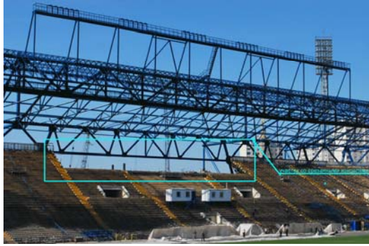
Рис. 5. Общий вид Западной трибуны на момент реконструкции (апрель 2009). Старая VIP-ложа демонтирована
