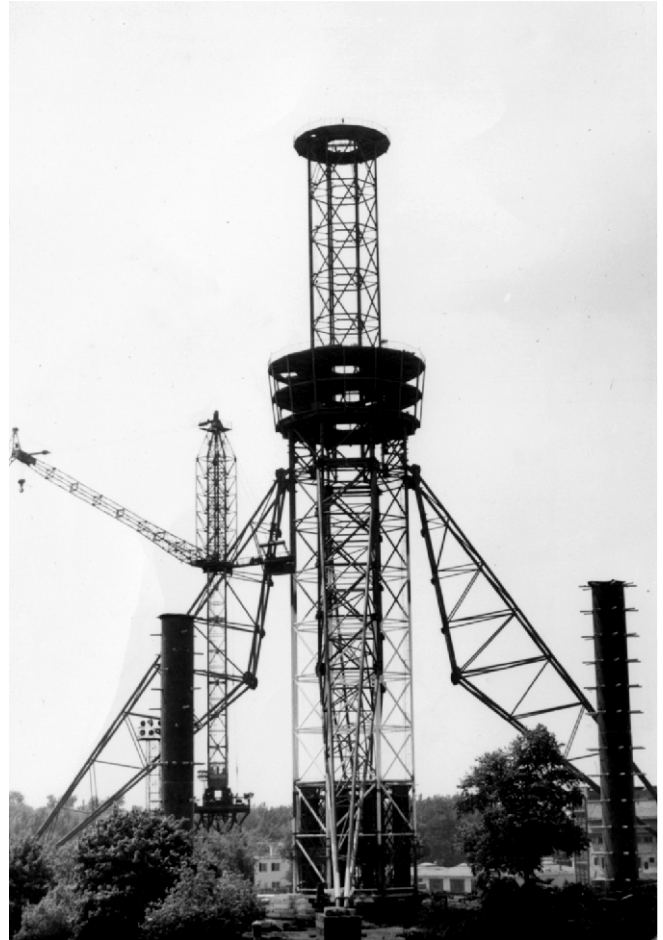
Рис. 3. Возведение базы «зонтиком» (промежуточное положение опор-ног базы)
