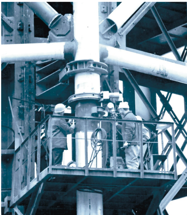
Рис. 1. Откидная монтажная площадка для выполнения автоматической сварки
