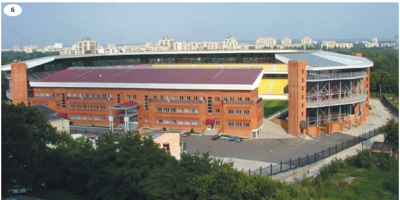
Рис. 1. Загальний зовнішній вигляд стадіону «Ювілейний» з південної (а) та західної (б) сторін
