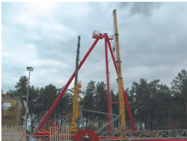
Рис. 4. Стыковка опор № 1 и № 2
