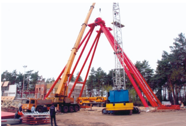
Рис. 6. Монтаж центрального опорного блока
