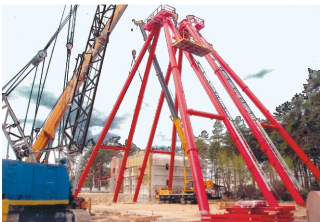
Рис. 5. Окончательный этап монтажа опоры № 4
