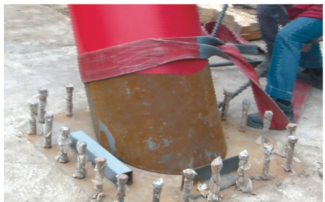
Рис. 1. Опорная плита с опертой на нее секцией опоры
