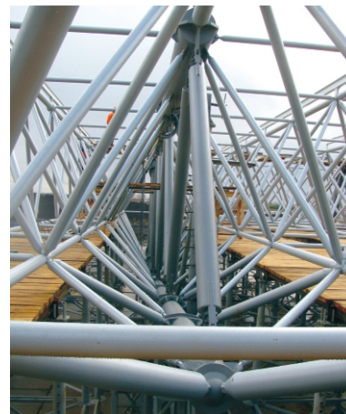
Рис. 12. Укрупнення металевих конструкцій покриття на стандах у монтажні блоки
