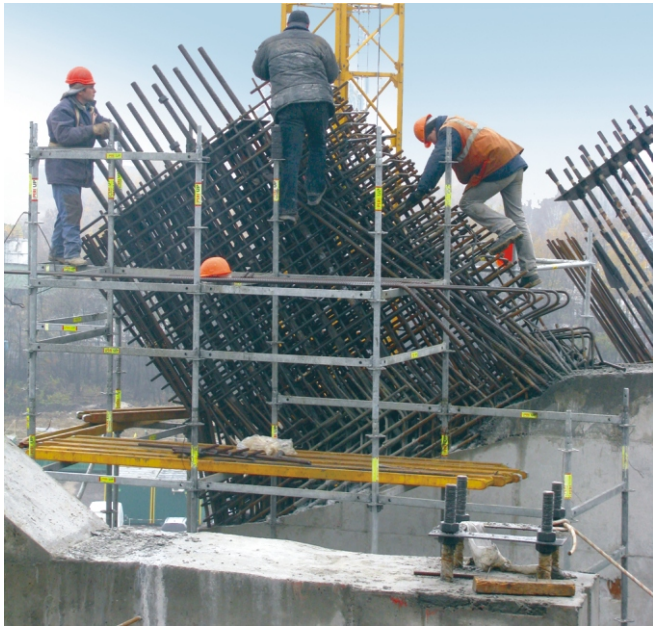
Рис. 5. Армвання оголовків залізобетонних пілонів із анкерними пристроями у зонах кріплення кроквяних ферм покриття
