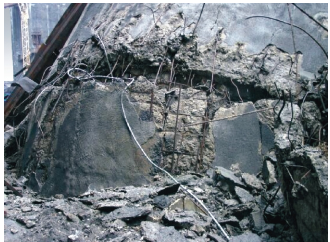
Рис. 1. Обвалення силосів через корозійне враження арматури
