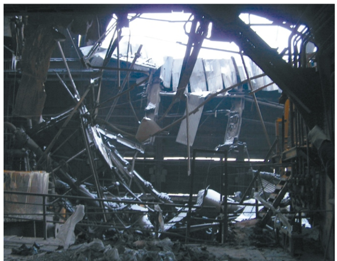
Рис. 2. Аварійний стан покрівлі мартенівського цеху
