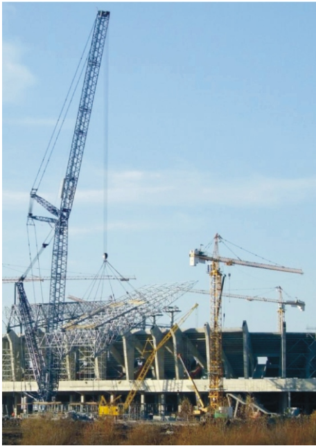
Рис. 13. Встановлення монтажних блоків покриття у проектне положення
