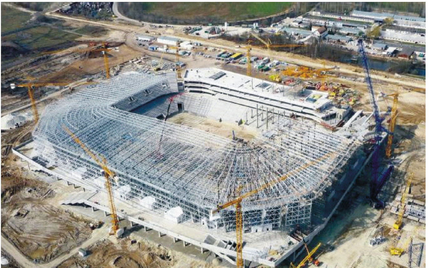
Рис. 15. Загальний вигляд змонтованих металокаркасних покриттів стадіону «Арена-Львів»
