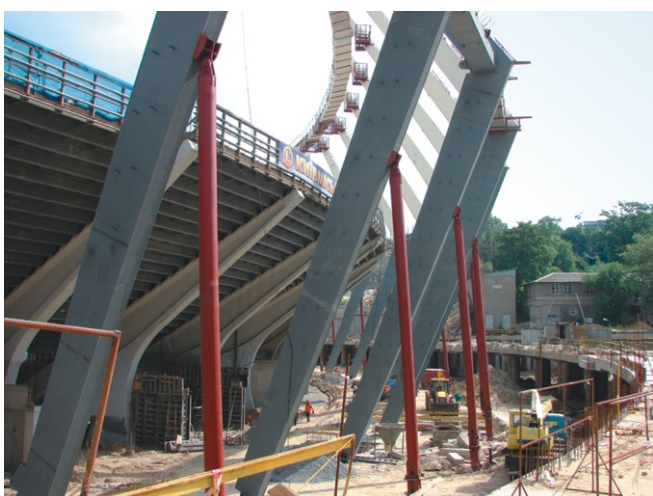
Рис. 10. Установка подпорок под колонны на время монтажа (до замыкания системы)
