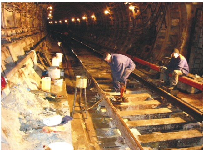
Рис. 3. Усунення течі на ділянці тунелю біля станції метрополітену «Академмістечко» ін'єкційним способом з використанням матеріалів комплексу «Моноліт КМТ»
