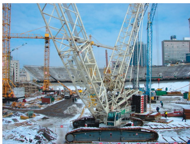
Рис. 11. Подъем колонны в сборе краном Demag грузоподъемностью 600 т
