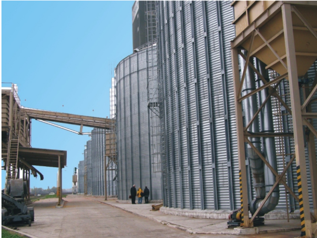
Рис. 1. Загальний вигляд силосів для зберігання зерна з хвилястою стінкою і плоским днищем
