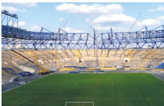
Рис. 8. Монтаж металевих конструкцій покриття стадіону ОСК «Металіст»
