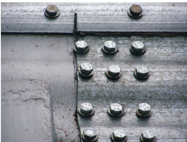
Рис. 3. Характерні дефекти монтажу конструкцій силосу в зоні воріт (підрізи верхньої панелі, зменшення відстані між кромкою листа та крайнім отвором болтового з'єднання)
