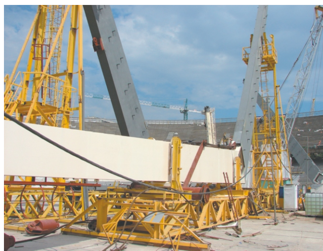
Рис. 8. Сборочные стенды для укрупнения колонн на монтажной площадке
