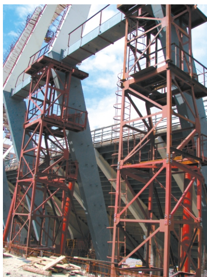
Рис. 9. Переставные опорные башни для установки и выверки колонн
