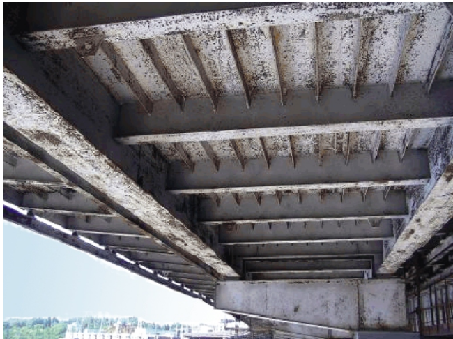
Рис. 1. Технічний стан металоконструкцій автопроїзду на греблі «Дніпрогес» у м. Запоріжжі
