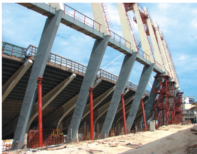
Рис. 7. Процесс монтажа опорного контура навеса
