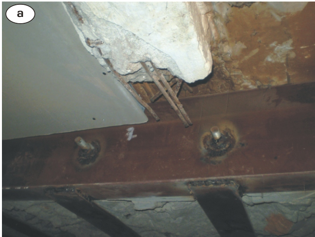
Рис. 1. Грубе порушення технології влаштування прорізу у цегляній несучій стіні (а) та спосіб відновлення несучої здатності системи (б)
