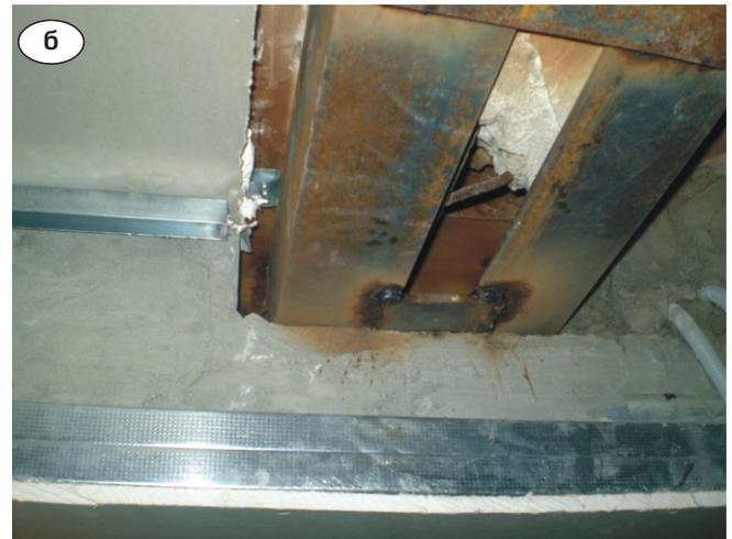
Рис. 1. Грубе порушення технології влаштування прорізу у цегляній несучій стіні (а) та спосіб відновлення несучої здатності системи (б)
