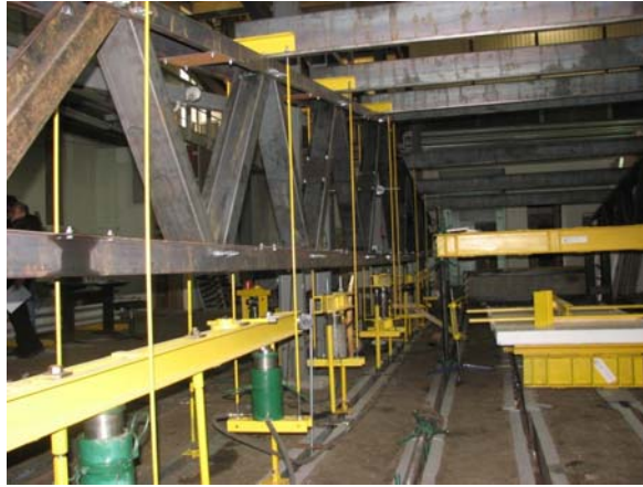
Рис. 6. Розміщення випробувальних приладів на конструкції
