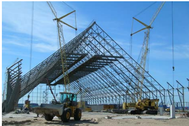
Рис. 1. Зведення поперечних рам каркаса складської будівлі
