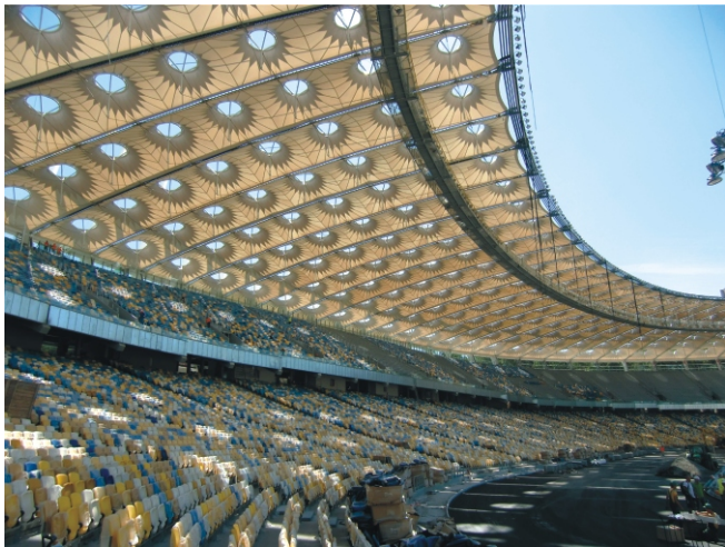
Рис. 5. Вантово-тентовое покрытие над трибунами (в процессе возведения)
