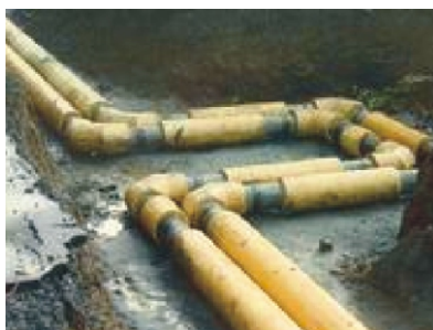
Рис. 6. П-образный компенсатор
