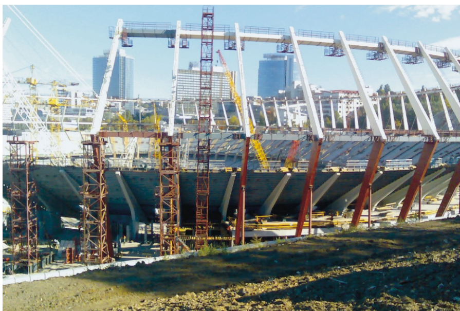
Рис. 4. Фрагмент несущего каркаса навеса (в процессе монтажа)
