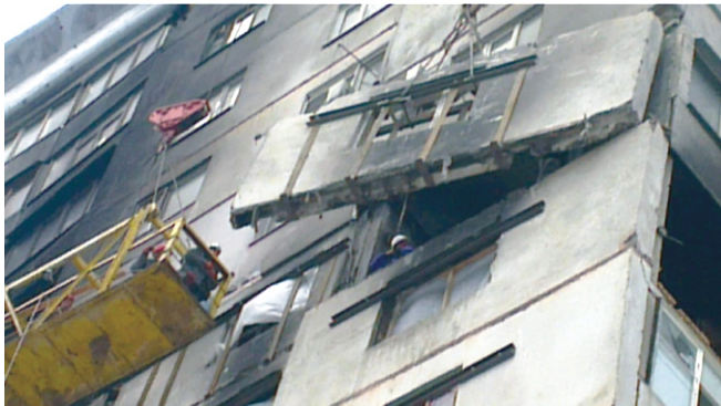
Рис. 5. Демонтаж деформированной стеновой панели
