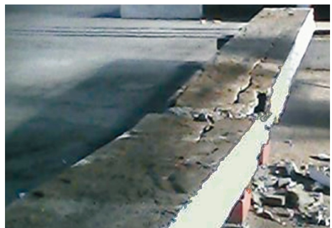
Рис. 6. Характер разрушения плиты 0,9 12 м
