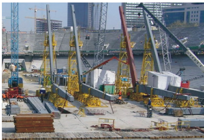
Рис. 6. Загальний вигляд стендів для укрупнювального складання колон на монтажному майданчику
