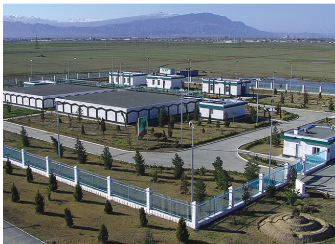
Водозабір із підземних джерел водопостачання м. Рухабат (Туркменістан)
