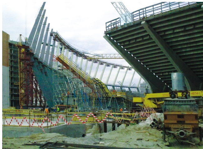
Реконструкція НСК «Олімпійський». Дренажні системи та системи будівельного водозниження (м. Київ)
