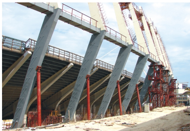
Рис. 8. Підпірки під колони на період монтажу
