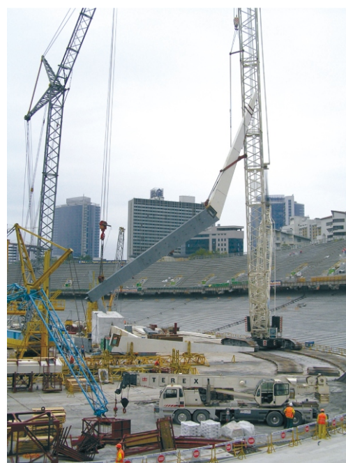
Рис. 9. Монтаж колони кранами Demag CC 2800-1 і СКГ-100
