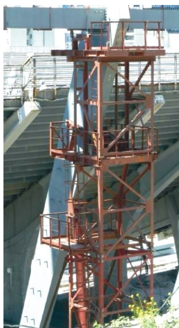
Рис. 7. Переставні вежі для встановлення колон у проектне положення і регулювання їх геометрії
