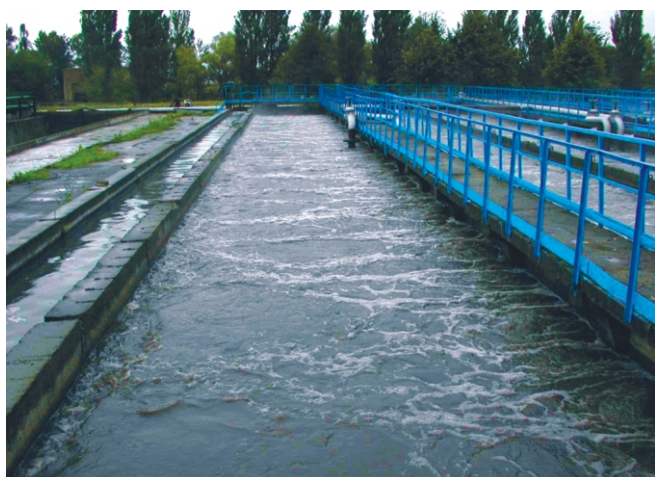
Каналізаційні очисні споруди. Аеротенки (м. Біла Церква)
