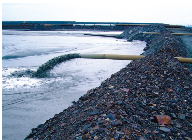
Процес намивання карти хвостосховища (ПАТ «Інгулецький ГЗК»)
