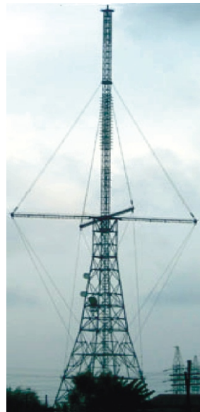
Рис. 5. Телевизионная опора с шпренгельным подкреплением антенны
