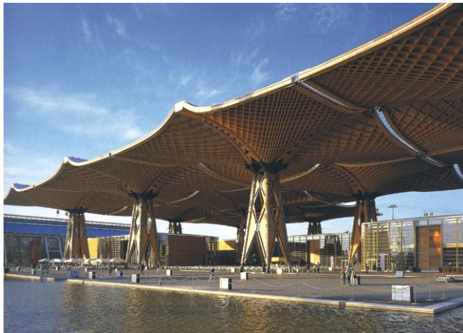
Рис. 1. Главный павильон («еврокрыша»)
