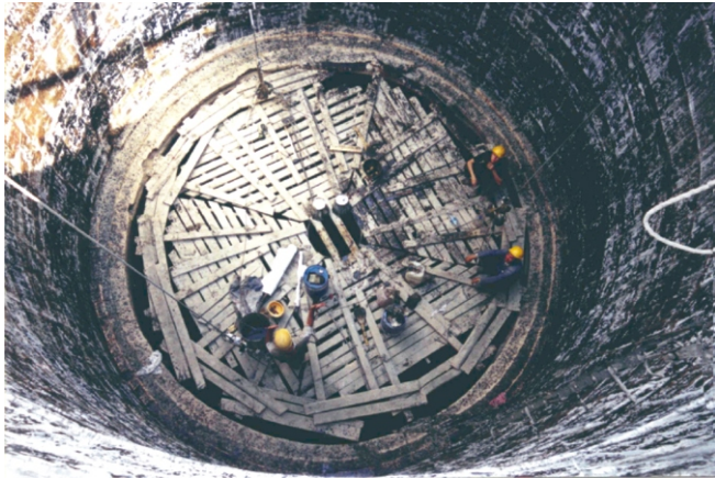
Рис. 1. Вид площадки сверху при проведении работ вблизи оголовка трубы
