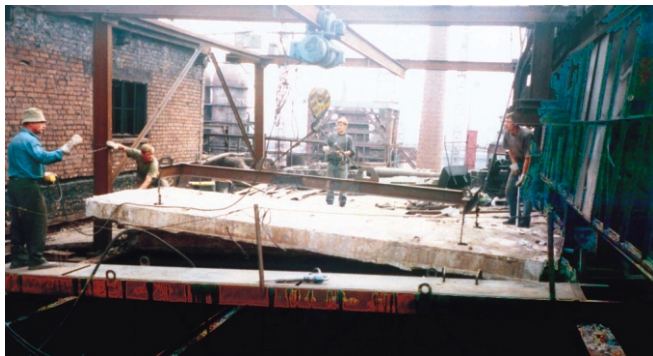
Рис. 4. Демонтаж плит покрытия с использованием эстакады и специальной траверсы
