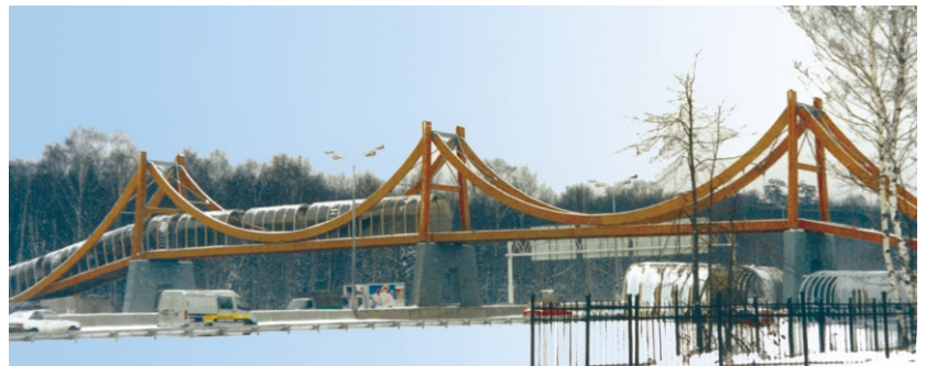
Рис. 16. Пешеходный переход через МКАД
