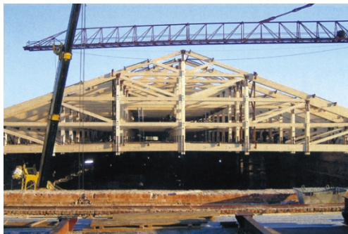
Рис. 15. Реконструкция покрытия манежа
