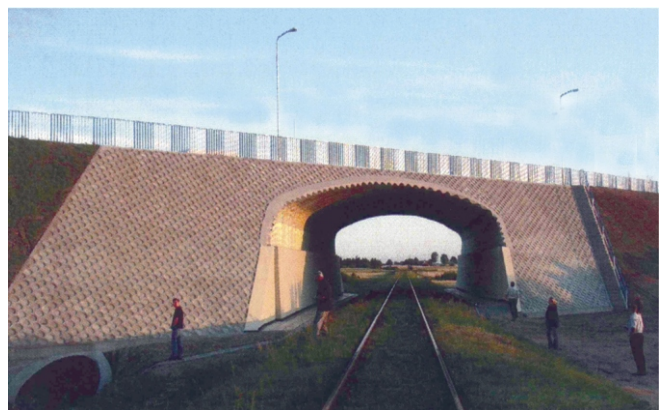
Рис. 5. Вид збоку на віадук дороги, розташований над залізничною колією в м. Пруднік (Польща)
