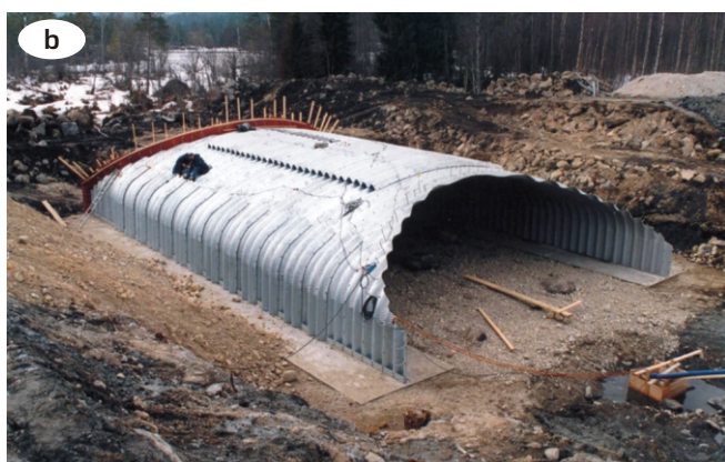
Рис. 3. Міст типу ґрунт-сталь, виготовлений з гофрованих листів (Швеція): a – вид збоку закінченого моста; b – сталева оболонкова конструкція до засипки
