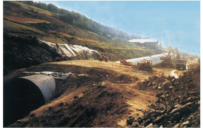
Рис. 4. Будівництво довгого тунелю з гофрованих листів у м. Хаф'ель (Норвегія)
