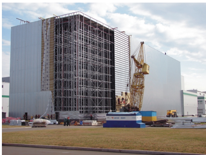
Рис. 3. Монтаж здания складского помещения фирмы «Дарница»
