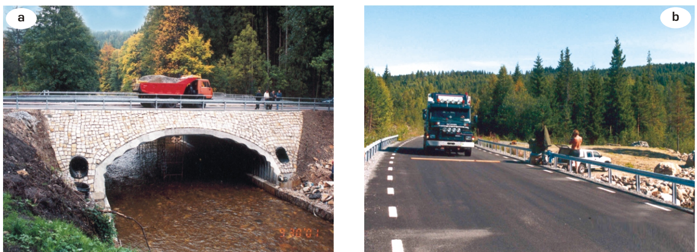
Рис. 10. Мости типу ґрунт-сталь:
