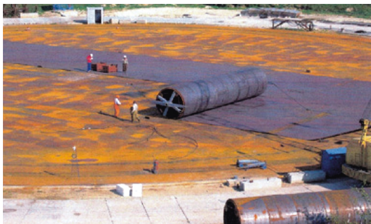
Рис. 1. Розгортка рулону днища резервуара об'ємом 75000 м 3
