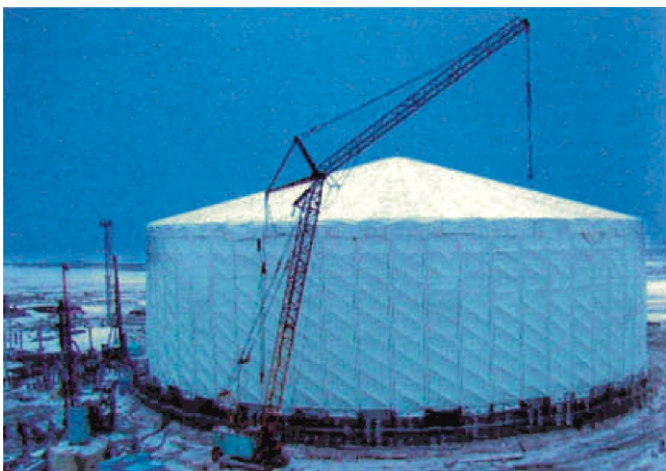
Рис. 8. Проведення антикорозійних робіт у несприятливих кліматичних умовах
