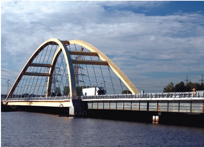
Рис. 1. Арочный мост через р. Большая Охта в г. Санкт-Петербург
