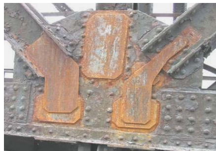
Рис. 8. Восстановление несущей способности узлового соединения
