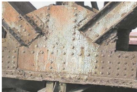
Рис. 7. Коррозионный износ элементов узла
