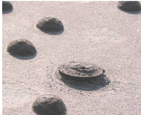
Рис. 5. Восстановление головки заклепки постановкой шайб на электросварке
