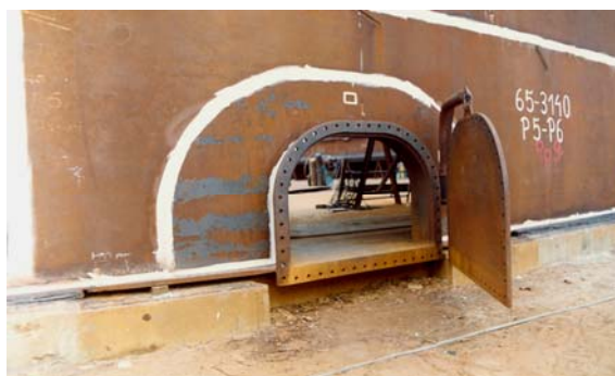
Рис. 2. Вид придонного очистного люка в резервуаре
