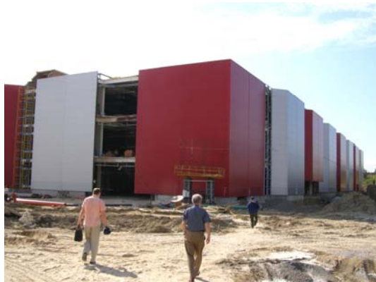
Рис. 1. Фрагменты главного и бокового фасадов здания
