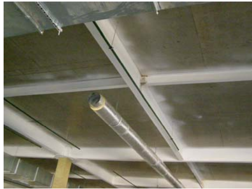
Рис. 2. Общий вид стальных балок и колонн каркаса
