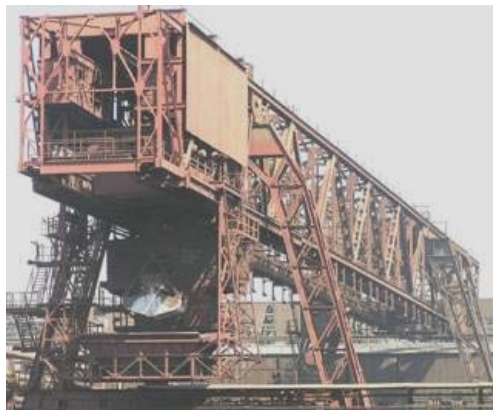
Рис. 1. Общий вид РГК-2 со стороны шарнирной опоры
