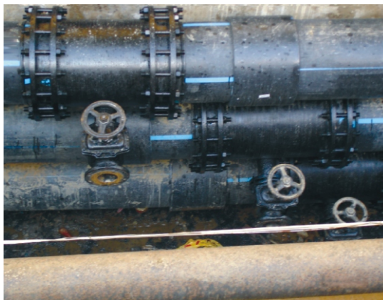
Рис. 5. Арматура для опорожнения коммуникаций в одном из колодцев магистрали
