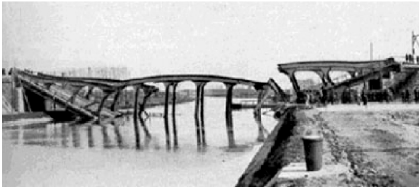
Рис. 6. Обрушение моста через канал Альберта
