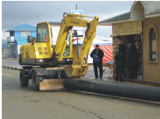
Рис. 3. Проталкивание полиэтиленовой трубы в коммуникационный тоннель экскаватором «Hyundai»
