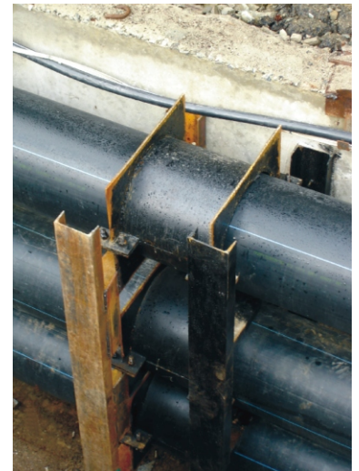
Рис. 6. Узел крепления трубопроводов к опоре
