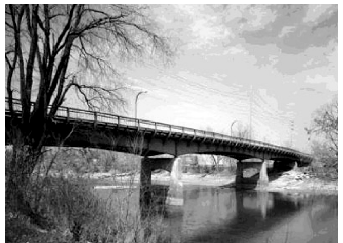
Рис. 5. Мост Benton Street Bridge
