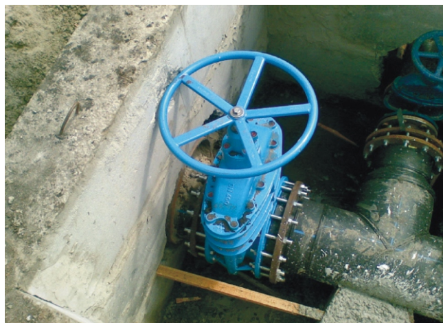
Рис. 1. Смещение запорной арматуры в результате линейной деформации полиэтиленового трубопровода
