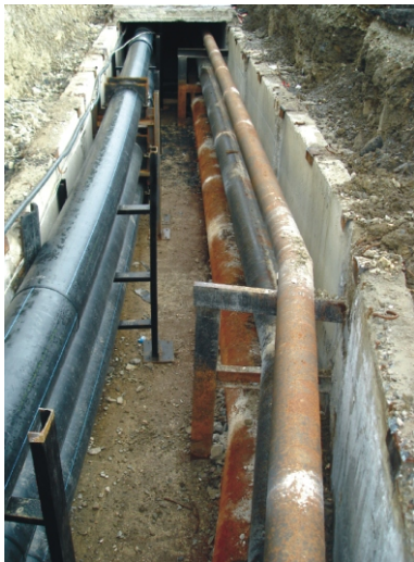
Рис. 2. Коммуникационный тоннель с существующим (правая стена) и вновь смонтированными (левая стена) трубопроводами
