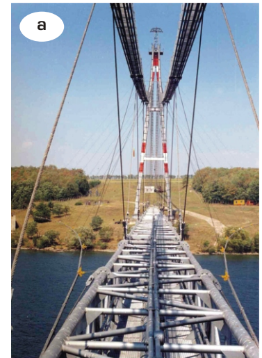
Рис. 1. Висячий переход аммиакопровода через р. Днепр: а – общий вид; б – вид с пилона правого берега
