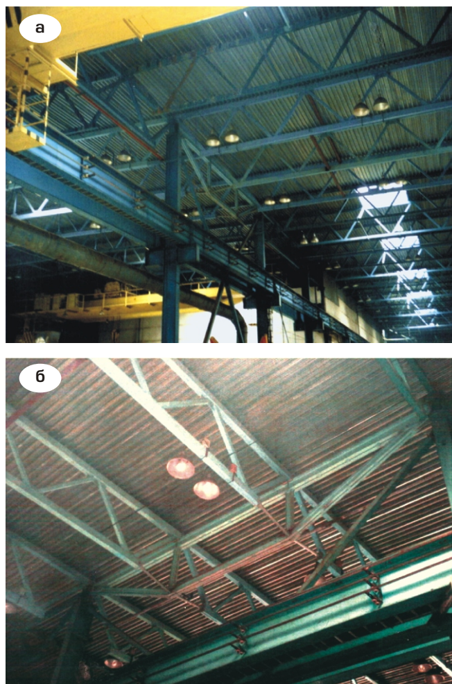
Рис. 6. Використання запропонованої підкрівляної балко-ферми прогоном 12 м у перекритті цеху заводу експериментальних механічних випробувань у м. Львові: а – загальний вигляд; б – фрагмент
