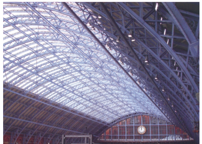
Рис. 3. Большепролетные стальные конструкции дебаркадера станции Св. Панкрас
