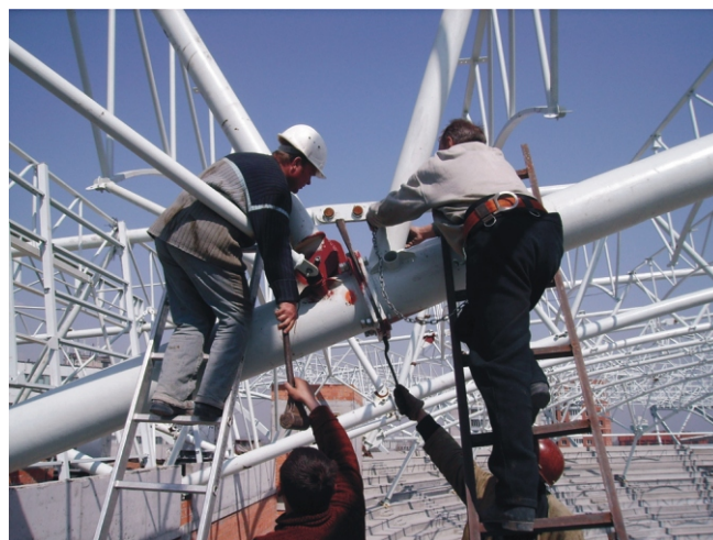
Рис. 11. Фланцеві з'єднання елементів ферм під час монтажу
