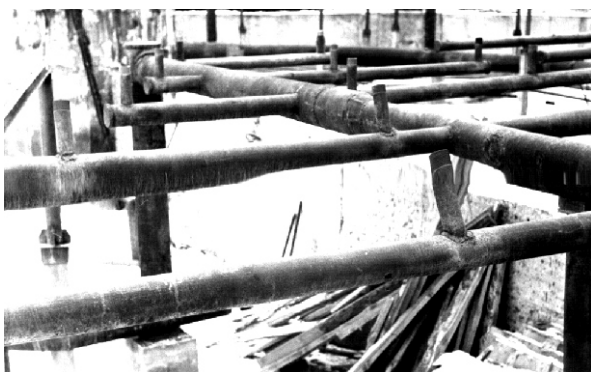
Рис. 7. Монтаж водораспределительной сети оросительной системы
