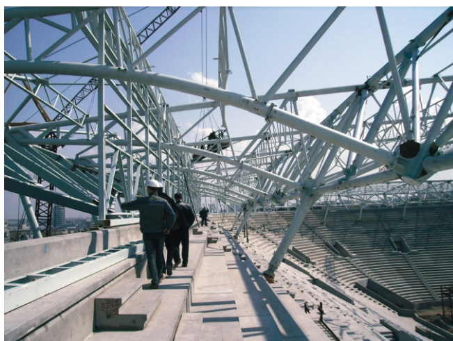
Рис. 10. Монтаж трубчастих ферм навісу
