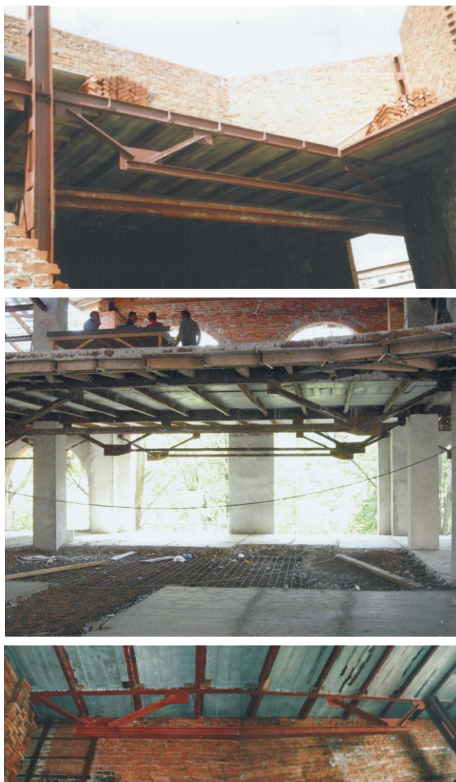
Рис. 5. Використання запропонованої балко-ферми у конструкції перекриття
