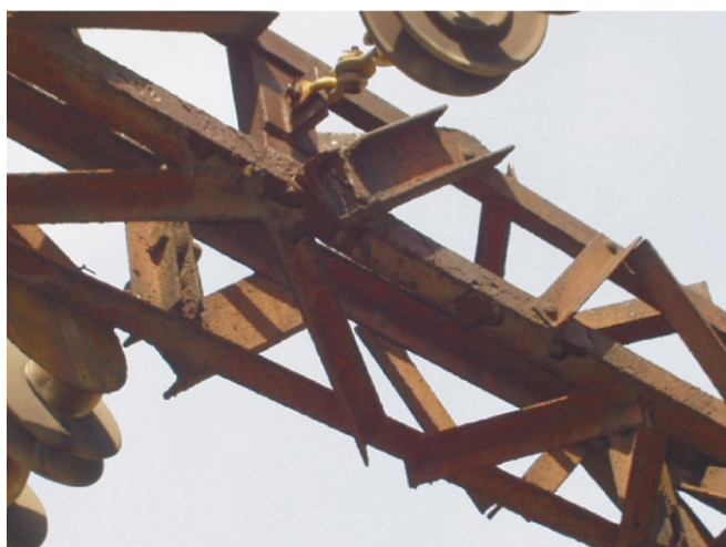
Рис. 2. Состояние конструкций подстанции «Донецкая» напряжением 110 кВ во время проведения обследовательских работ
