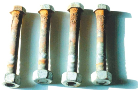
Рис. 5. Коррозионное повреждение высокопрочных болтов узла крепления прижимных планок
