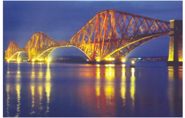
Рис. 1. Пролетные строения моста Форт Рэйл
