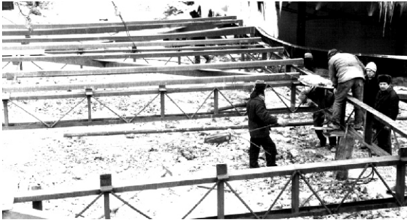
Рис. 5. Контрольная сборка монтажной карты градирни
