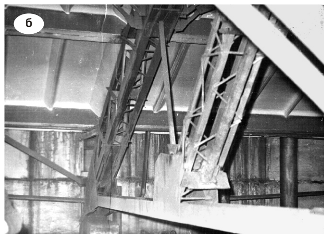
Рис. 7. Підсилення конструктивних елементів промислових об'єктів: а – колон цеху Калуського ВО «Нафтобурмашремонт»; б – розкосів ферм покриття прогоном 36 м котельні Бурштинської ТЕС
