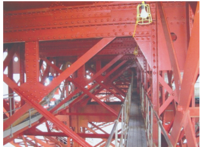
Рис. 2. Внешний вид стальных конструкций и их защитных покрытий после выполнения окрасочных работ
