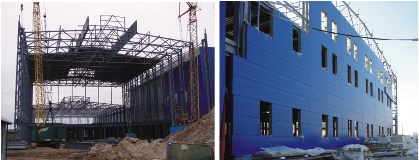
Рис. 3. Строительство корпуса № 5 ОАО «Ветропак Гостомельский стеклозавод»
