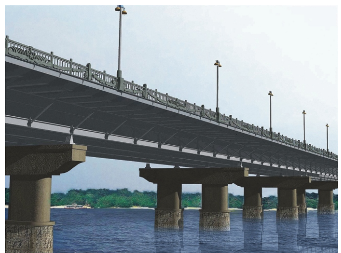
Рис. 1. Вид моста им. Е.О. Патона после реконструкции
