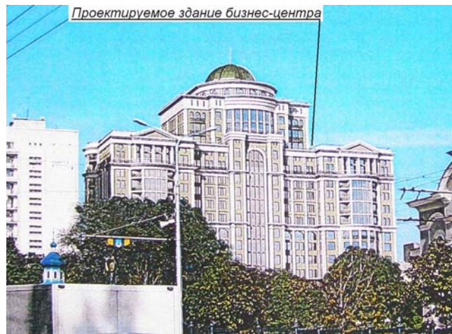
Рис. 1. Главный фасад здания бизнес-центра
