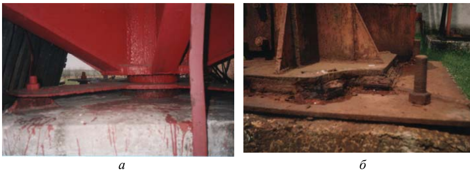
Рис. 3. Дефекты опорных узлов: а – мачты; б – башни
