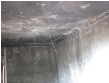
Рис. 4. Вигляд плити покриття після вогневих випробувань
