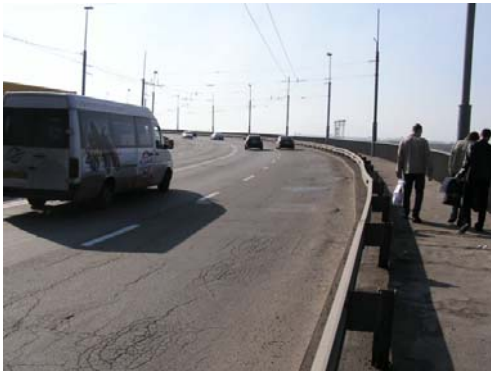
Рис. 17. Дефекты асфальтобетонного покрытия проезжей части
