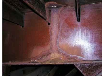
Рис. 10. Место разрушения грунтовки, поверхностная коррозия
