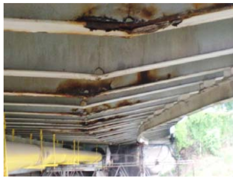
Рис. 8. Ослабленные сечения поперечных балок
