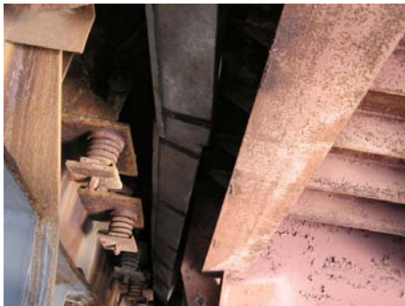
Рис. 15. Разрушение уравнильных приборов деформационных швов
