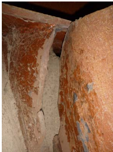
Рис. 4. Трещина и смещение кромок в стенке тяги
