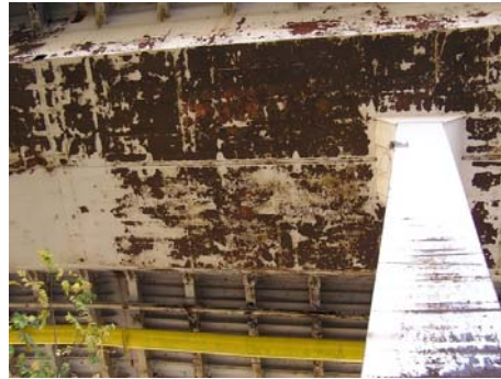
Рис. 14. Разрушение антикоррозионной защиты колонн и пролетного строения
