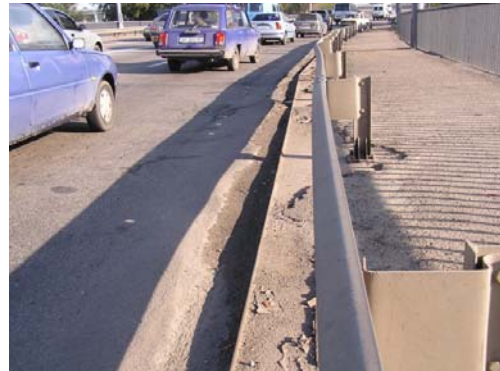
Рис. 18. Разрушение асфальтобетонного покрытия тротуаров
