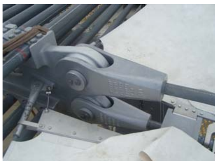
Рис. 10. Примикання ферми до кільця. Затискач троса для підвіски
