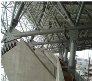
Рис. 12. Конструкції консольних ферм. Анкерні та стиснуті опори, шарнірні вузли
