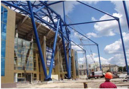
Рис. 5. V-подібні колони, стійки, тяги. Шарнірна підвіска до тяги
