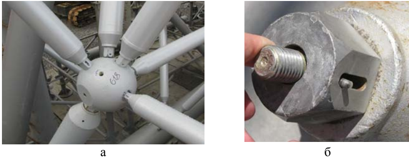
Рис. 17. Вузлова деталь для з'єднання стержневих елементів структури (а) та наконечник стержневого структурного елемента (б)
