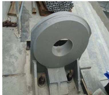
Рис. 12. Конструкції консольних ферм. Анкерні та стиснуті опори, шарнірні вузли
