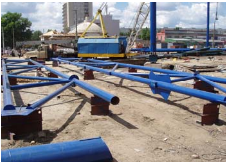
Рис. 6. Секції ферм. Окінцівки стрижня під монтаж
