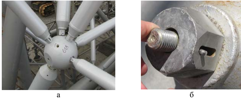
Рис. 5. Узловая деталь для соединения стержневых элементов структуры (а) и наконечник стержневого структурного элемента (б)
