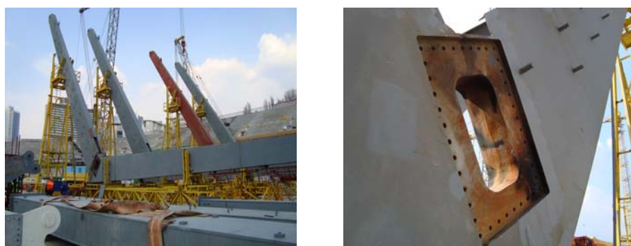
Рис. 8. Стиковані колони (FC + RC). Вузол примикання ригеля LCR
