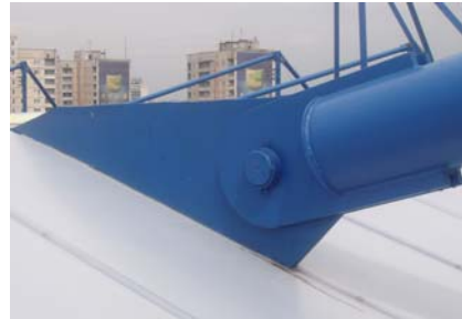
Рис. 5. V-подібні колони, стійки, тяги. Шарнірна підвіска до тяги
