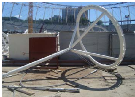
Рис. 11. Торець сегмента мембрани. Каркас підвісного ліхтаря
