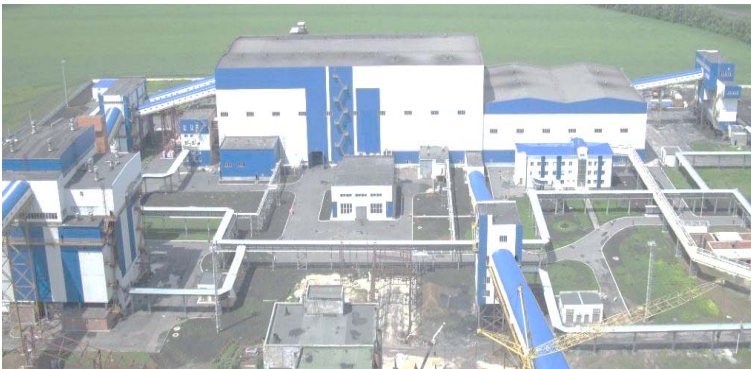
Рис. 1. Общий вид производственной площадки ОФ (в центре – главный корпус)
