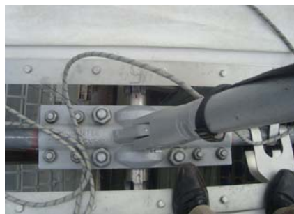
Рис. 10. Примикання ферми до кільця. Затискач троса для підвіски
