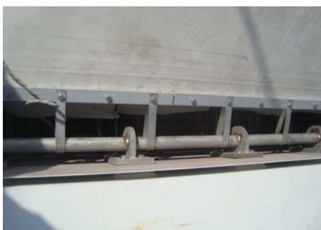
Рис. 11. Торець сегмента мембрани. Каркас підвісного ліхтаря
