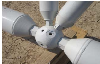
Рис. 4. Вузол структури «Меро»
