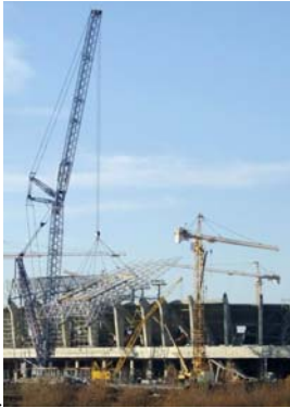
Рис. 11. Установка монтажного блока в проектное положение
