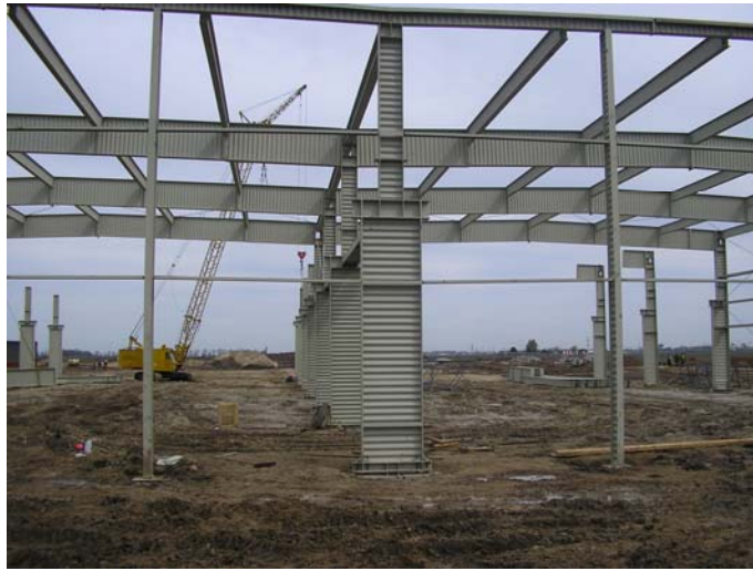
Рис. 1. Монтаж каркаса завода металлоконструкций в Киевской области
